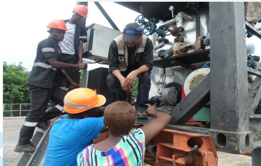
Suite formation par l'Ingénieur de la centrale DMI 100
