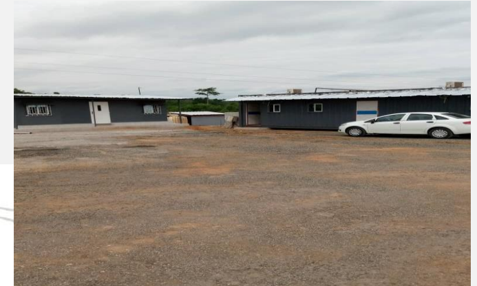
Bureau site de la centrale de production enrobé
