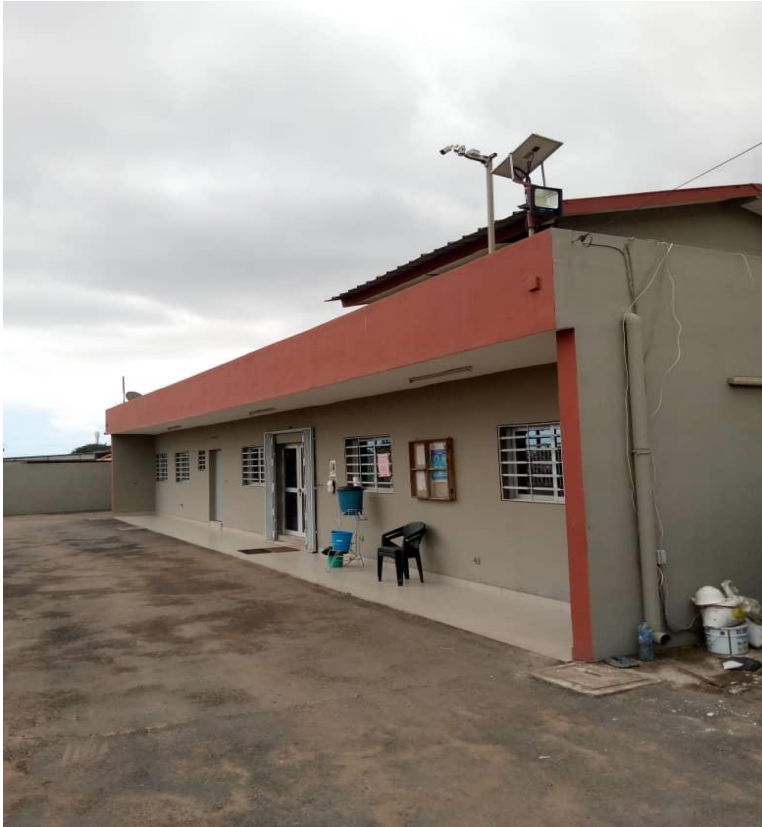
La Direction Générale sise à Yopougon zone indust./Andokoi/institut SOTRA
